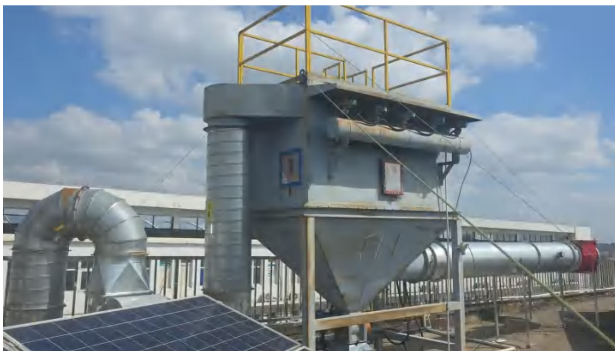
4#排气筒 脉冲除尘装置
