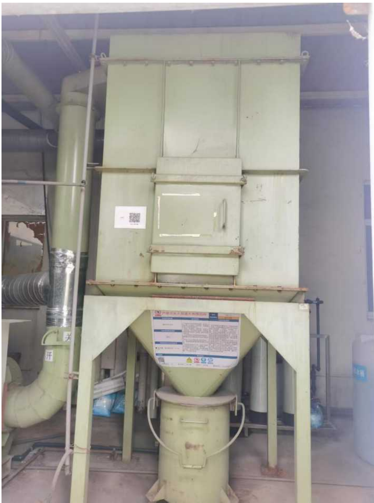
1#排气筒 袋式除尘装置
