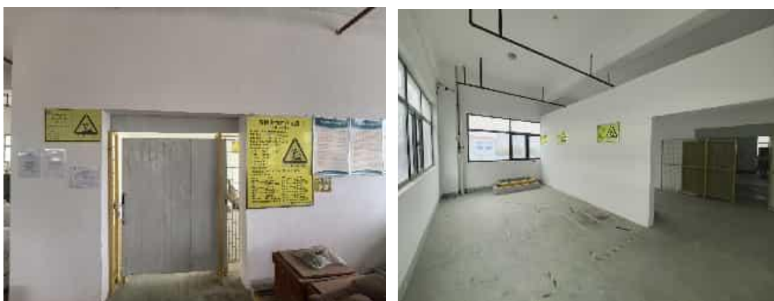
图 3-4 危废暂存场所及标识牌
