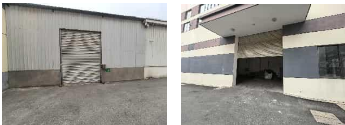
图 3-5 一般固废暂存场所及标识牌
